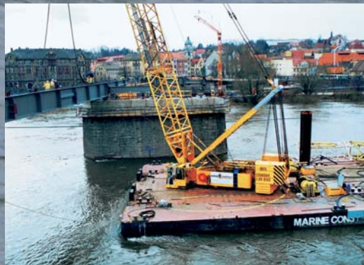
Im Februar 2000 stellte ein Schwimmkran den neuen Stahlüberbau der Brücke fertig.
