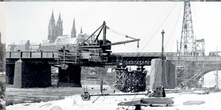
Auf neuen, schlanken Pfeilern entstand stromaufwärts der alten Brücke 1933/34 eine neue Straßenbrücke. Foto: Mitte Dezember 1933
